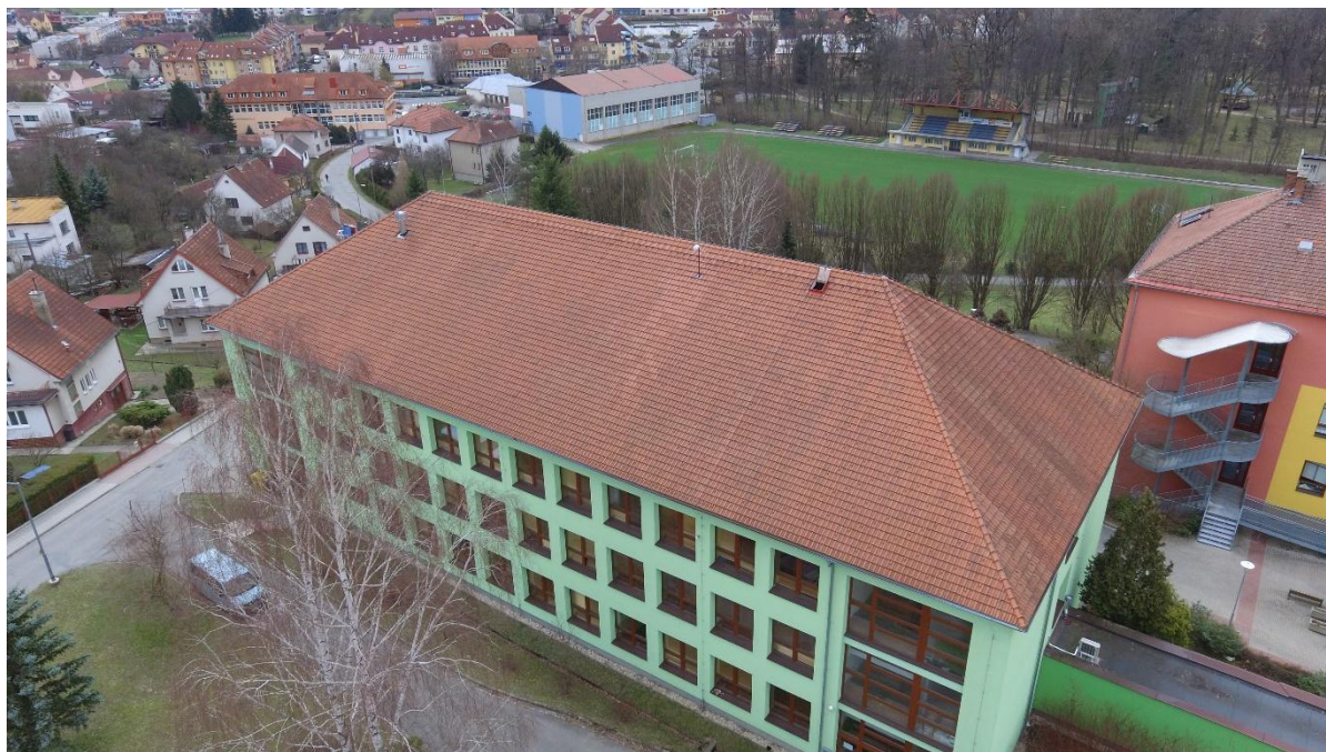
Obr. 6 Budova Gymnázia Jana Pivečky před rekonstrukcí střechy (vestavba 4. a 5. patra)
