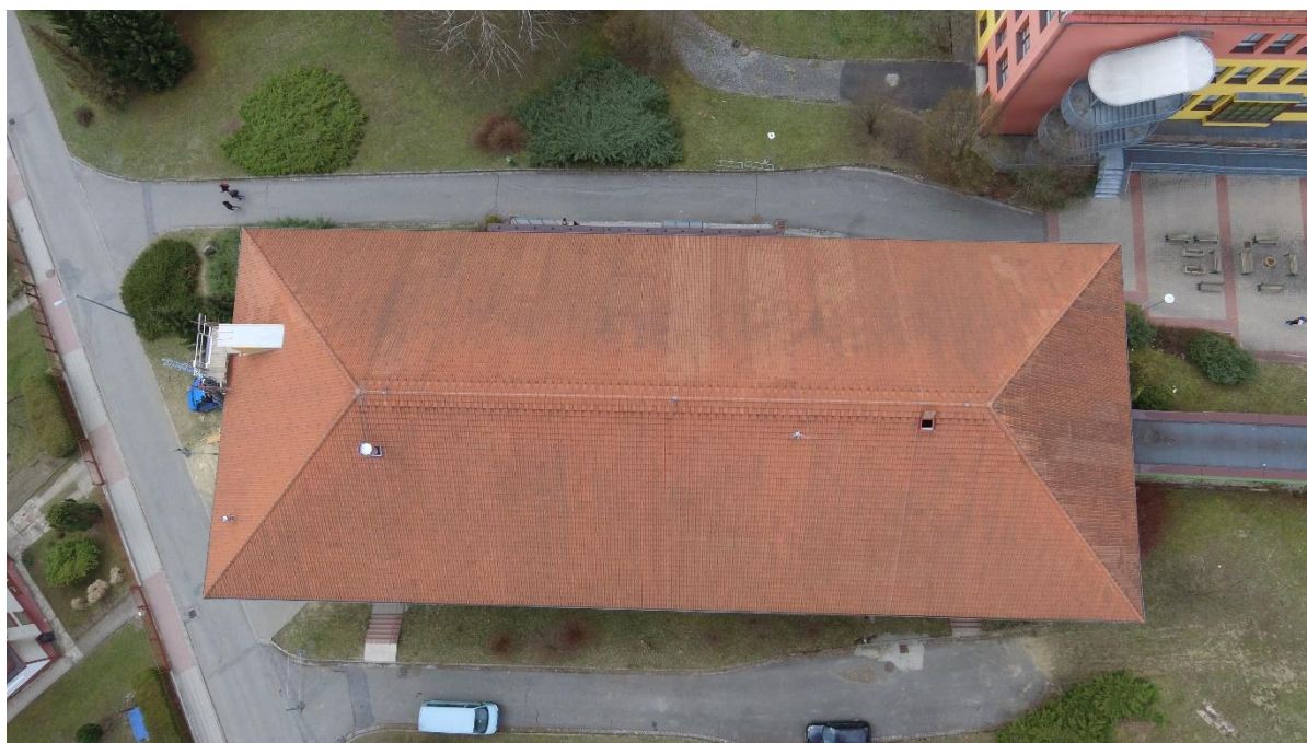
Obr. 7 Počínající rekonstrukce půdních prostor budovy Gymnázia Jana Pivečky ve Slavičíně
