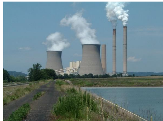
Obrázek 12.18. Tepelná elektrárna na hnědé uhlí
