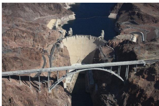
Obrázek 13.4. Stavba přehrad (Hoover Dam, Arizona, USA)
